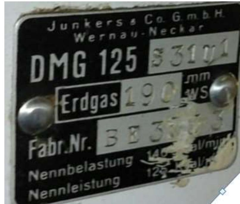
Gasgeräte, bei denen die CE- bzw. DVGW-Kennzeichnung fehlt
