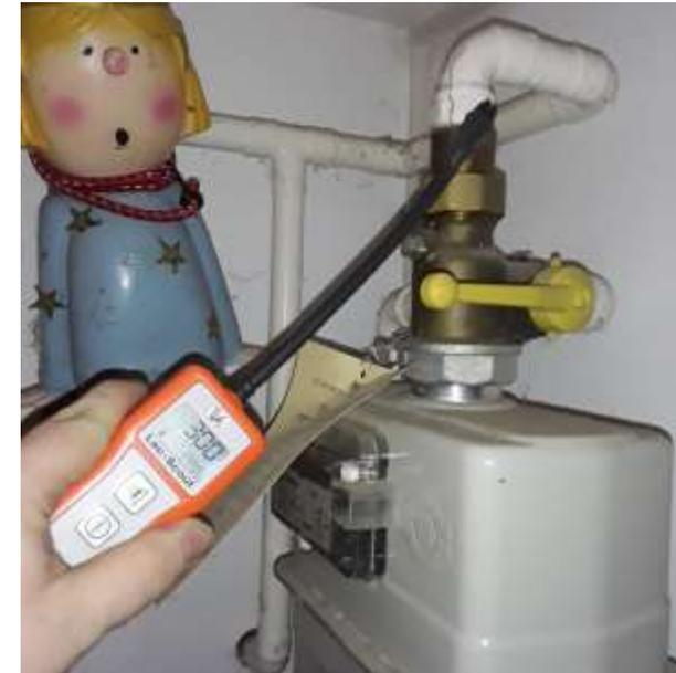
Gasundichtigkeit ( $\text{CH}_4$ ) im Bereich der Gasinstallationsleitung
