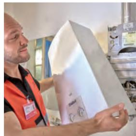
Bei jedem Gerät wird eine Sichtprüfung (Ist-zustandsanalyse), ggf. eine Abgasanalyse und Ionisationsstrommessung durchgeführt.
