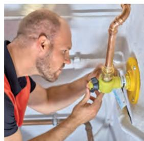
Die Leitungsanlage wird in Augenschein genommen, die Raumluft auf Methankonzentration überprüft und der Gaszählerstand erfasst.
